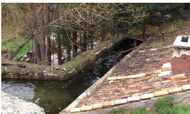
Vista de la antepara con los tiradores.
