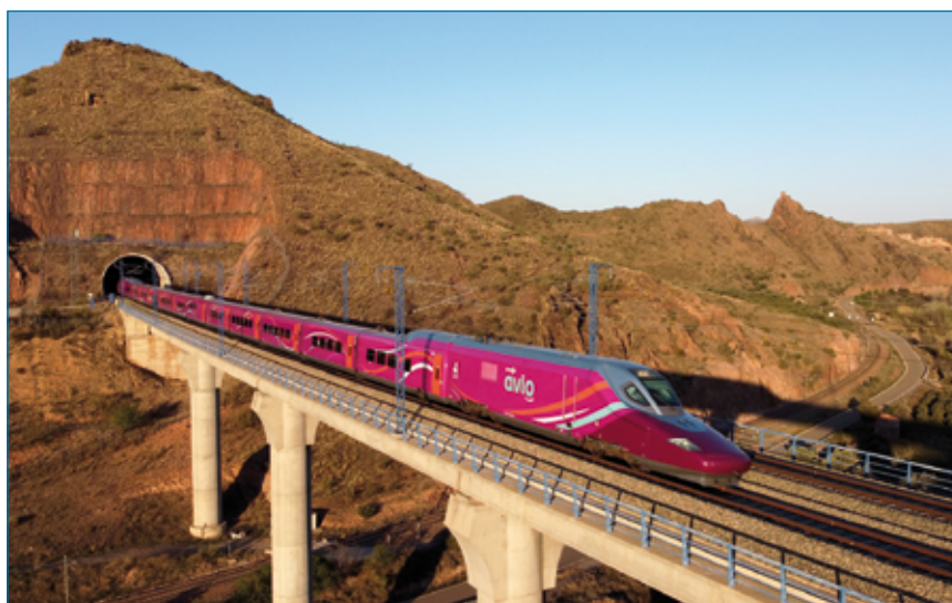
Renfe- AVLO. Viaducto del Jalón.
