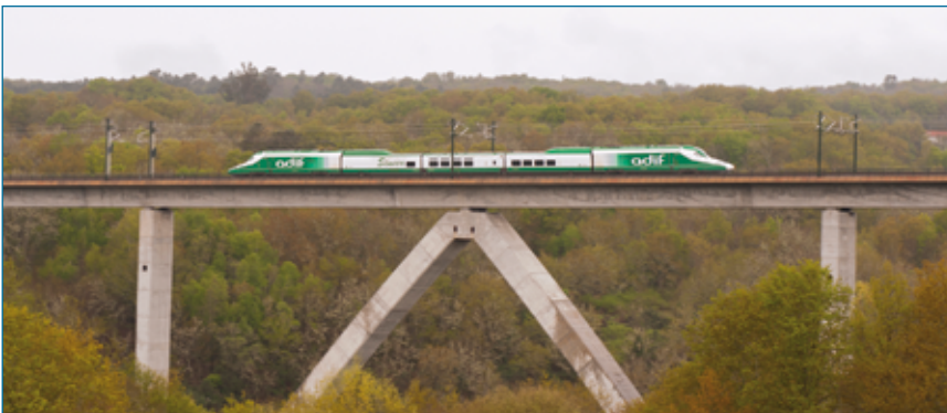
Pruebas tren Séneca. Viaducto Arnoia (Ourense).
