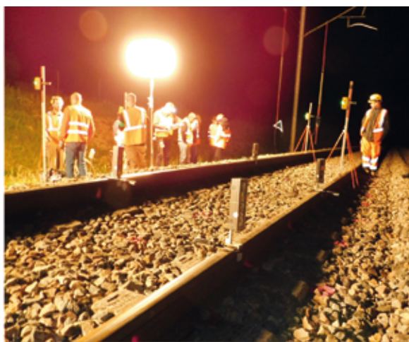
Instalación del sistema de vigilancia
