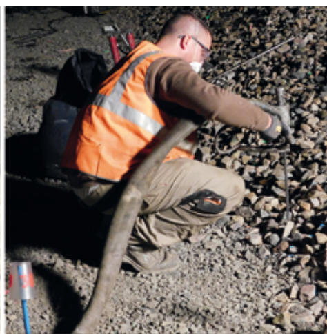
Realización de las inyecciones de resina
