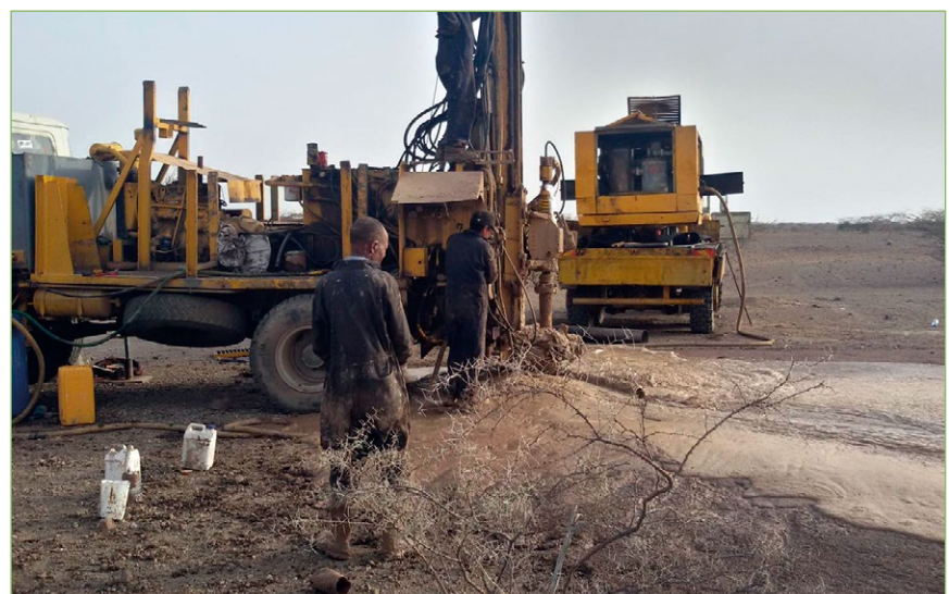
Perforación de un pozo.
